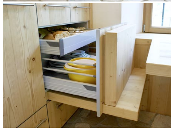
Verblüffendes Detail: Damit der Platz hinter der Sitzbank nicht verschwendet wird, hat die für den Küchenbau verantwortliche Tischlerei Gasser hinter schiebbaren Rückenlehnen zwei Auszüge angebracht.
